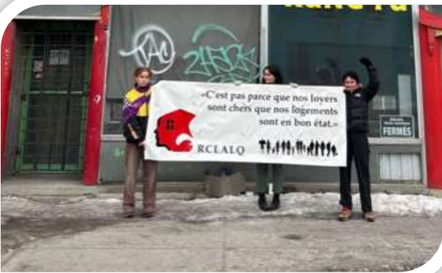
Immeuble sur Papineau insalubre
